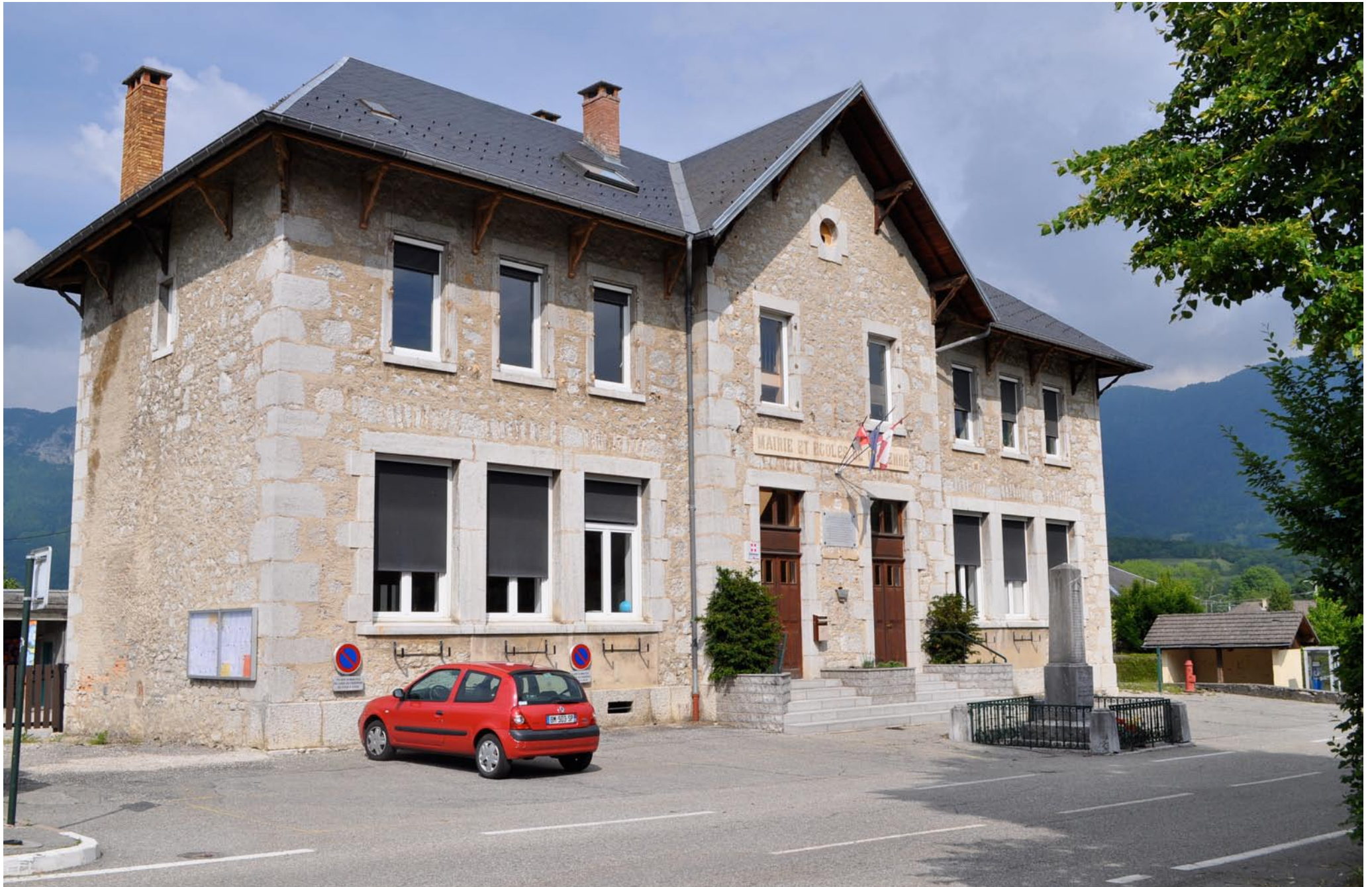
VUE DE LA MAIRIE DEPUIS LA RD11
