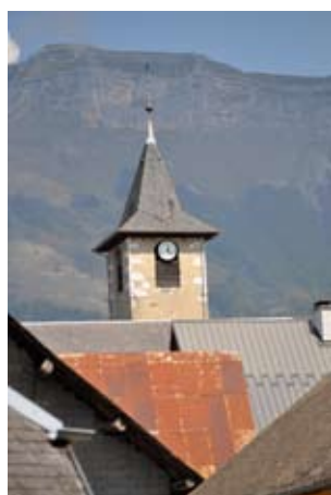
DENSITÉ DES TOITURES À THOIRY ET SUCCESSION BÂTIE À PUYGROS
