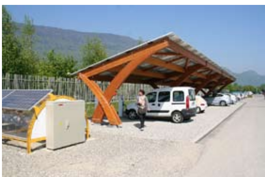
Ombrières de parking sur le site de l'INES (Savoie)
