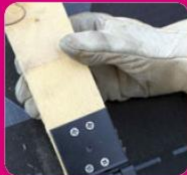
③ Positionnement et fixation des crochets
