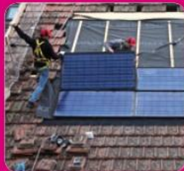
⑦ Montage des rangées de modules suivantes
