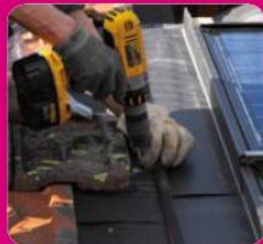
⑧ Pose des abergements de modules
