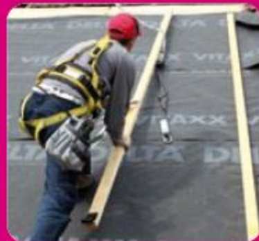
④ Positionnement des chevrons de modules
