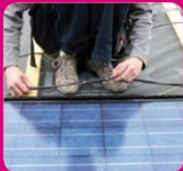
⑥ Raccordement des modules
