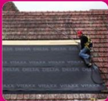
② Mise en place de l'écran de sous-toiture
